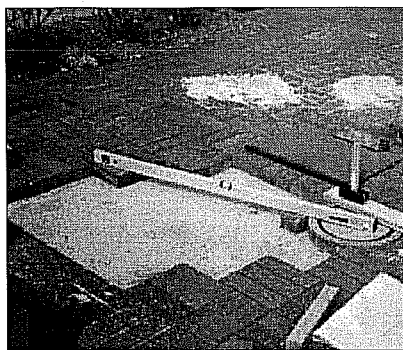
Ved brønddaksler og lignende opstår der ofte lunke pga. for dårlig komprimering eller manglende overhøjde ved lægningen. Oprettningen udføres dog let.
