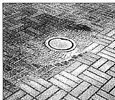
Lunker der giver vandsamlinger skal rettes op.
