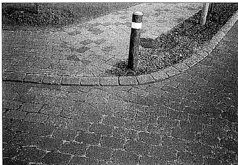
I denne belægning har der været gravet op for at reparere telekabler. Ved en omhyggelig og korrekt retablering kan det gøres uden ar i belægningen.
